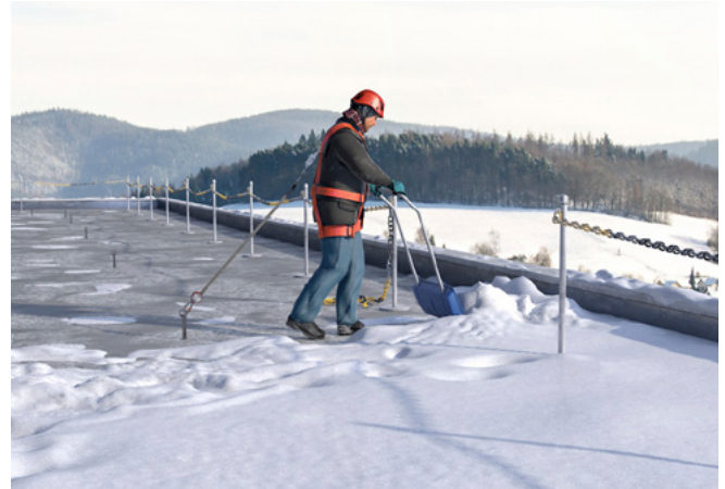
Abb. 7 Prinzip der Verwendung von Rückhaltesystem mit Schneewanne
