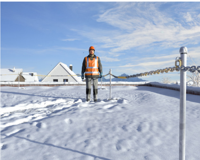
Abb. 19 Absperrung des Gefahrenbereichs mit einer Kette
