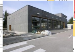
Fahrzeughalle mit Seminar- und Sozialgebäude
