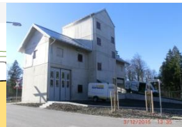
Lagerhaus mit Rampe
