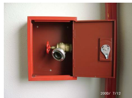
Entnahmestelle nach → DIN 14461-3
